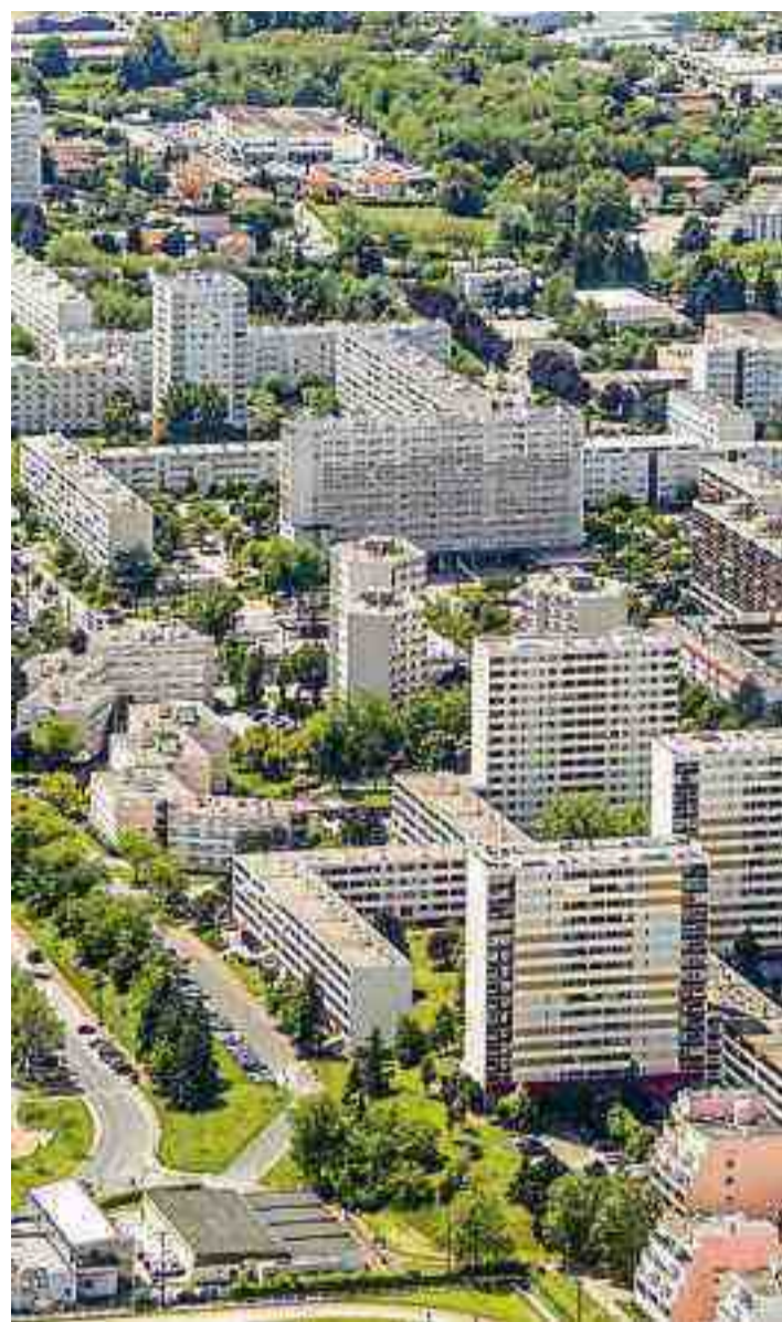
HLM à Rilleux-la-Pape, dans le Rhône. Photo Laurent Grandguillot/RÉA
